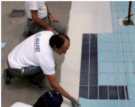
Montaż płytek ceramicznych na warstwie hydroizolacji Mapelastastic Zero
