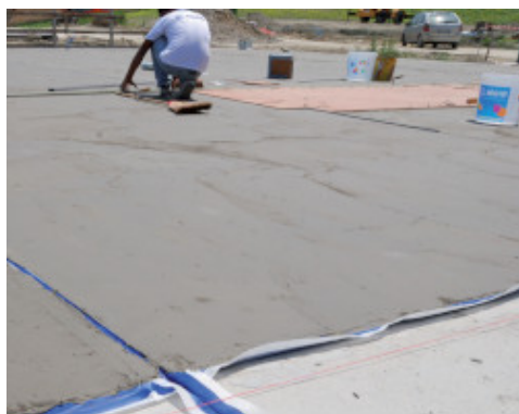
Hydroizolacja powierzchni dachów z zastosowaniem Mapelastic Zero i Mapeband
