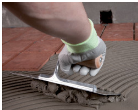
Montaż płytek na zaprawie klejącej Granirapid na wykonanej uprzednio hydroizolacji Mapelastastic Zero
