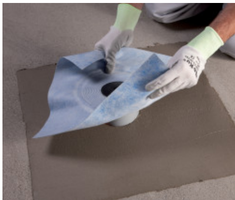
Montaż Drain Vertical na Mapelastastic Zero
