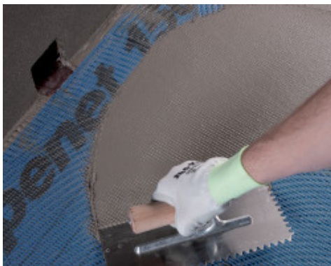
Rozprowadzanie hydroizolacji Mapelastastic Zero na siatce Mapenet 150
