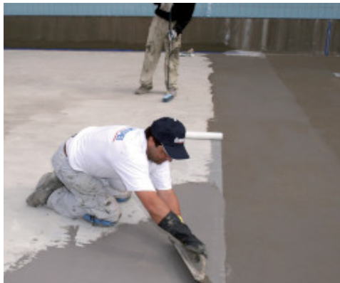
Hydroizolacja basenu z zastosowaniem Mapelastastic Zero
