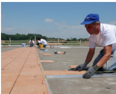
Montaż płytek ceramicznych z zastosowaniem Kerabond TE + Isolastic
